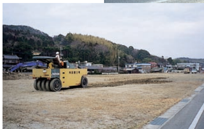
廃材を片づけた後の整地作業
