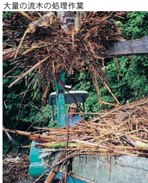
大量の流木の処理作業
