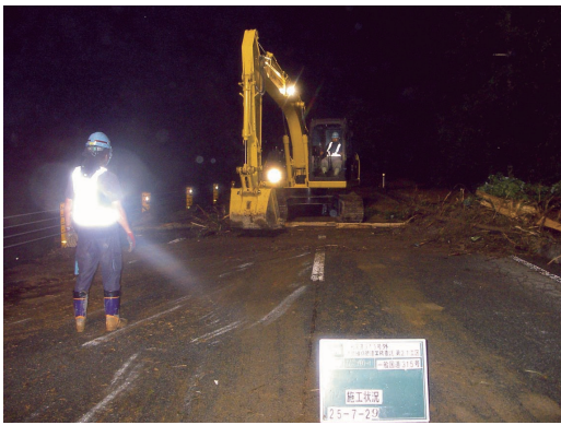
道路の復旧作業 (山口支部 [阿東地域])
