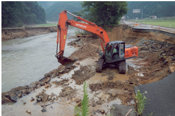
洪水により削り取られた護岸の復旧 (山口支部 [阿東地域])
