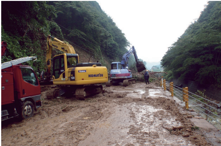
道路の復旧作業 (山口支部 [阿東地域])
