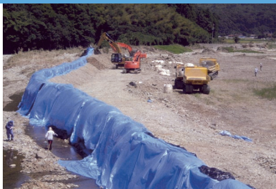
護岸の復旧作業 (萩支部)
