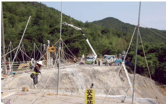
道路の復旧作業 (萩支部)
