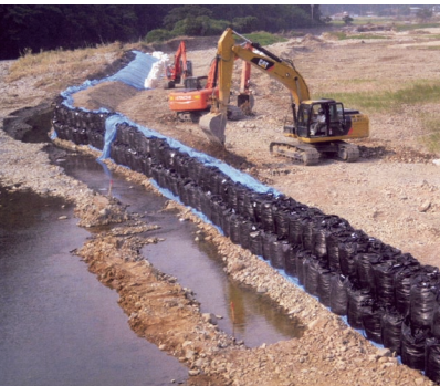
護岸の復旧作業 (萩支部)
