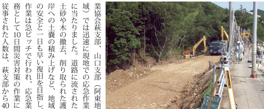
道路の復旧作業 (萩支部)
