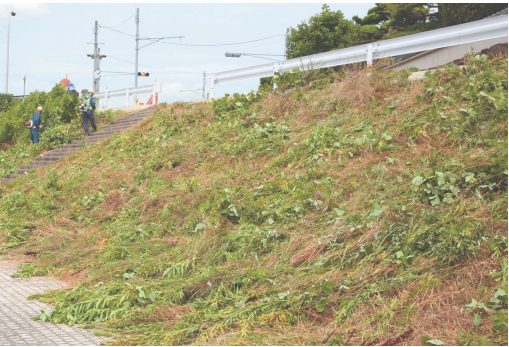
草を刈った後の法面
