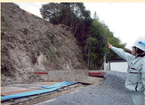
3月に完成予定の現場
