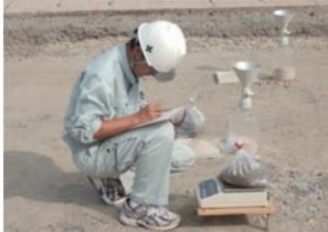
1日目は、旧下松清掃工場跡地での土壌汚染調査でした。まず電動ビックでアスファルトに穴を開け、そこからダブルスコップで穴を掘って土試料の採取をしました。どちらの道具もはじめて見るものですが、丁寧に一つずつやり方やコツを教えてくださったおかげで、なんとか採取することができました。土試料採取後は、掘った穴を埋め戻し、レミフアルトで固めて元の状態に戻しました。この際も、現状戻しが基本であるなどを教えていただき、目の前で見えていることだけが仕事ではなく、その前後の動きが重要であることがよく分かりました。
