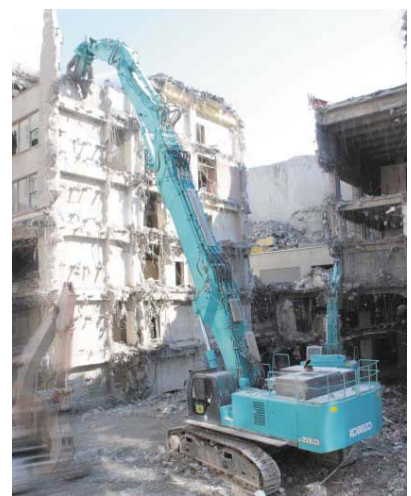
特定解体用機械のコンクリート圧碎機 コベルコ建機(株)製、同社提供
